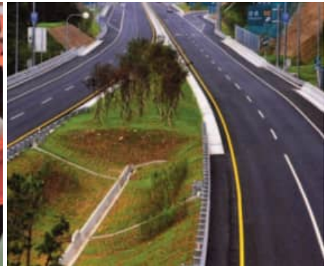
■ 서울 - 춘천 고속도로 개통 / 2009 Opening of the Seoul-Cuncheon Expressway
