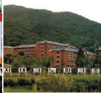
■ 원주테크노파크 부지 선정 / 1998 Site Preparation works for Wonju Techno Park
